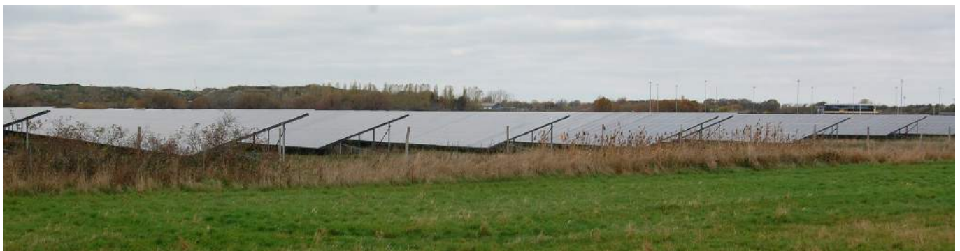
Solcellepark ved Væggerløse
